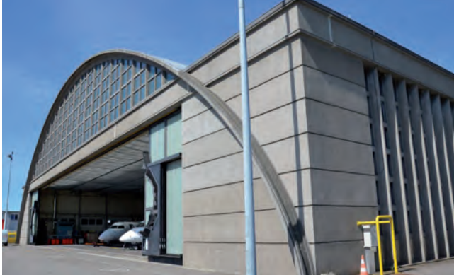
Abb.52: Blick auf den geschützten Hangar
